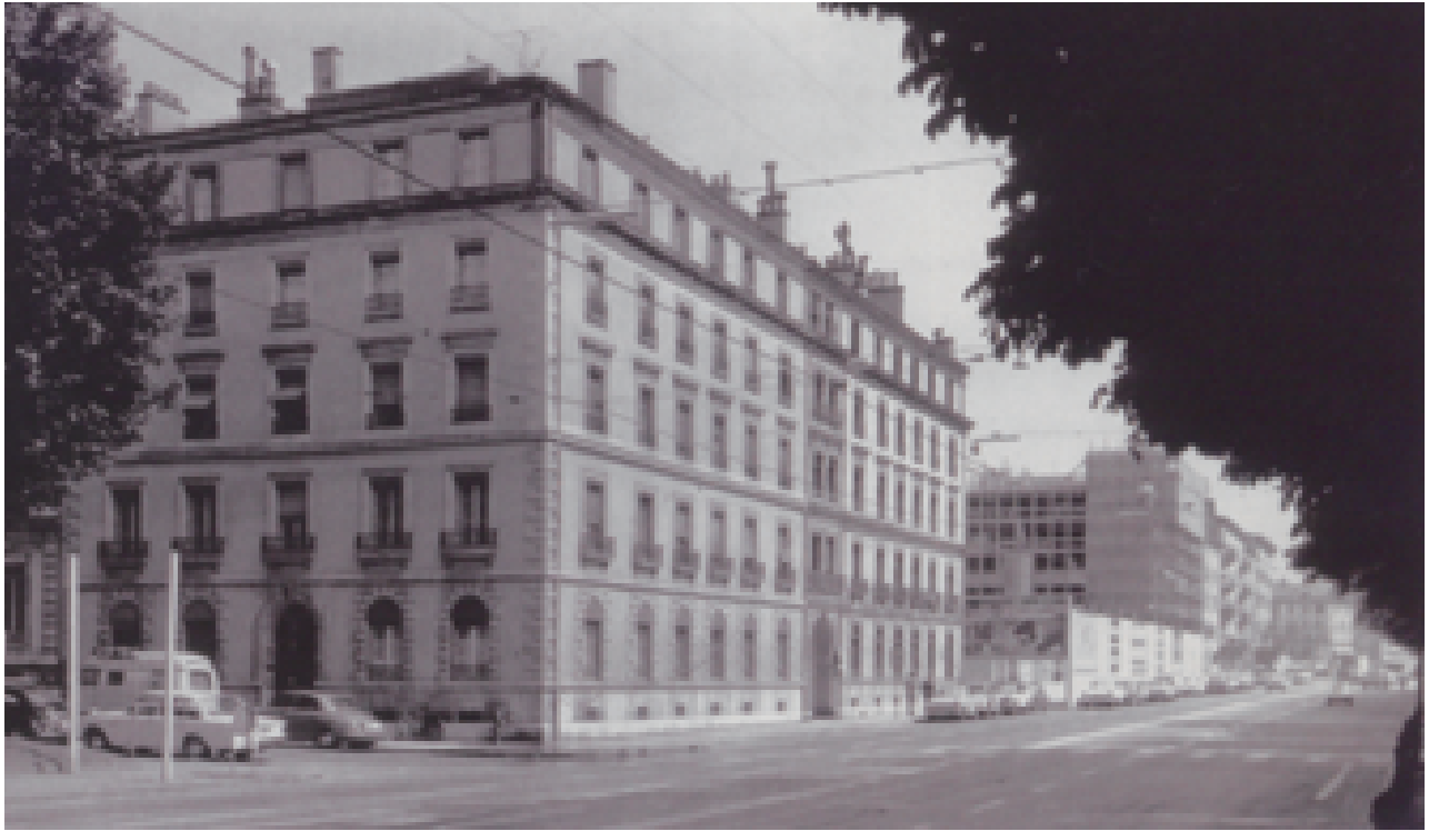
ピクテの新社屋を建設する前の ジョルジュ・ファヴオン大通り
