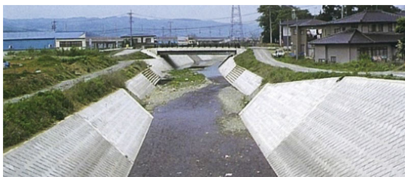
河川改修工事後
